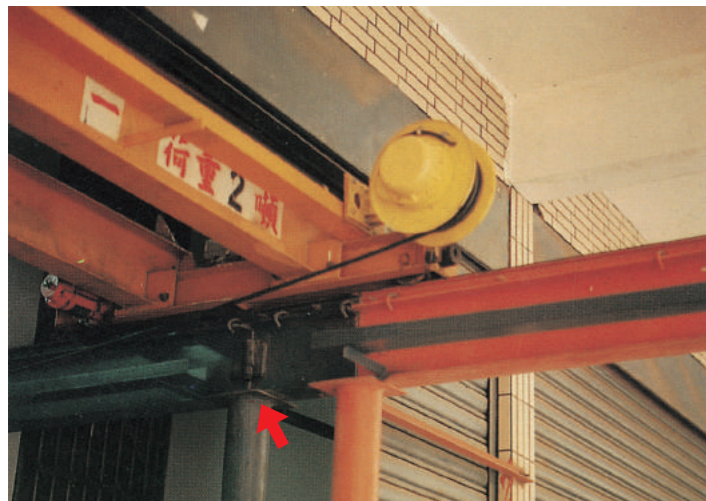
免破壞修改電動捲門，可延伸出騎樓，只需工字鐵加裝樞紐摺合，即可下門。
