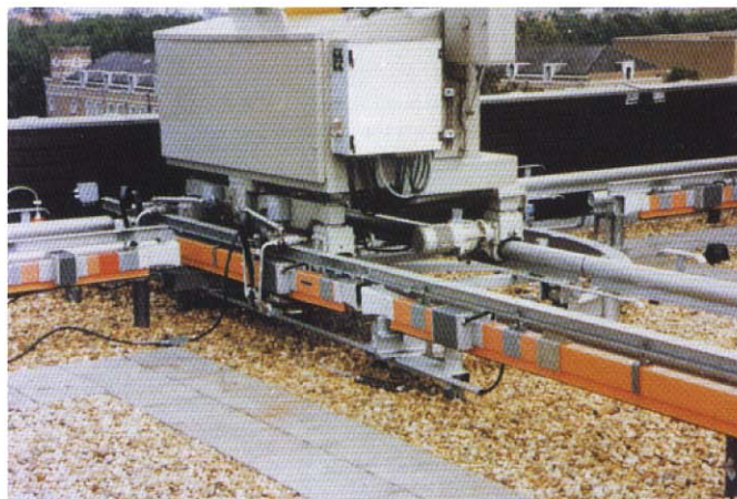
屋頂洗窗機用(可換軌系統)
